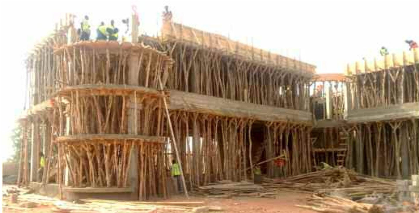
Vue des travaux de construction du siège du Conseil Régional du Centre à Ouaga 2000
